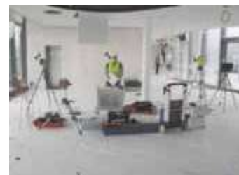
/ Modernste Aufmaßtechnik mittels 3D-Laserscanning ist Standard.
